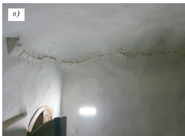
Рис. 2. Деформування несучих елементів Церкви Різдва Христова:
